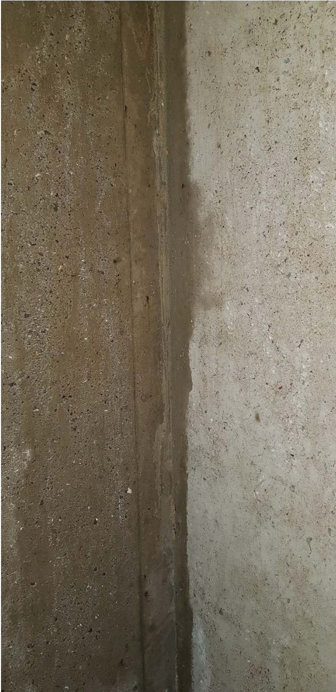
Eckenbereich nach Entfernen der Putzreste. Bei den weißen Stellen im Beton handelt es sich um Steine
