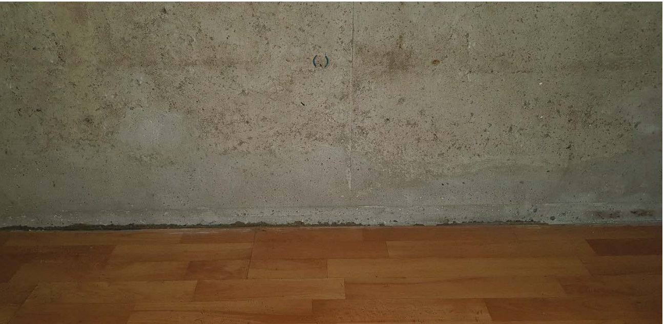
Unterer Wandbereich nach Entfernen der Putzreste
