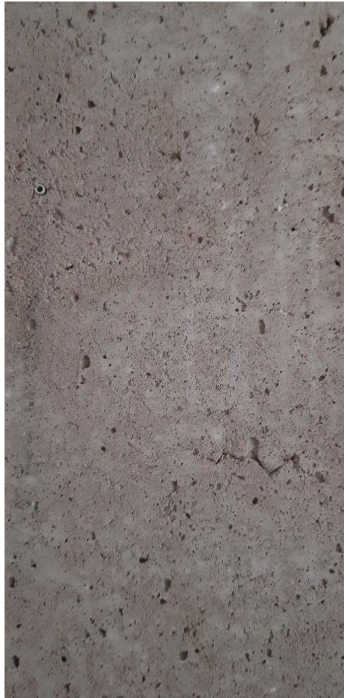
Nahaufnahme der Wand nach Entfernen des Putzes. Durch die Wasserstrahltechnik wird der Putz aus allen Vertiefungen im Beton entfernt.
